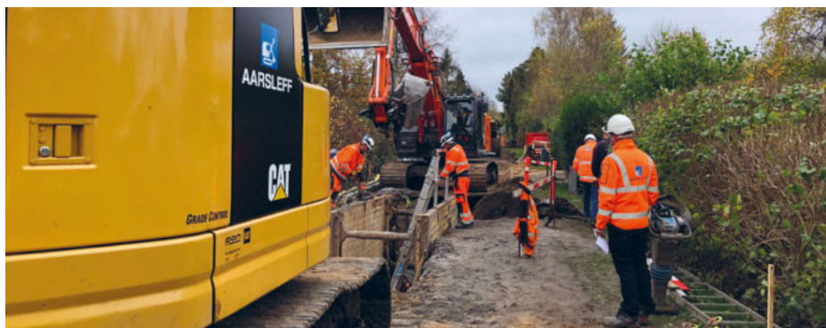
Det er Odsherred Forsyning, der står for kloakeringen af sommerhusene. Foto: Odsherred Forsyning.
